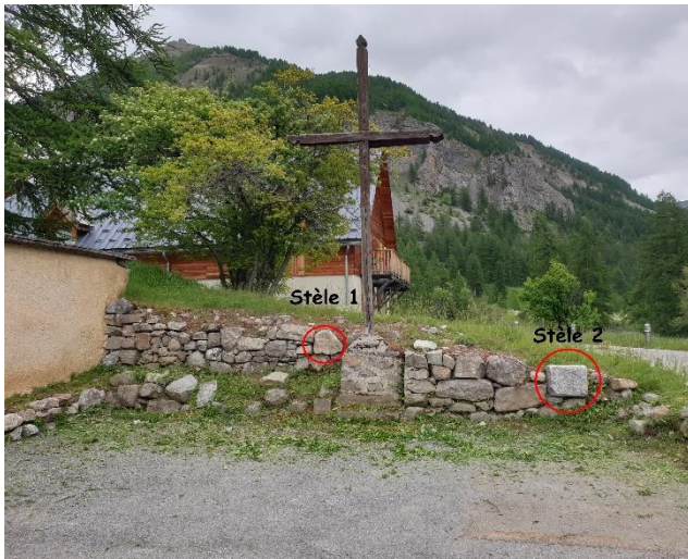
Fig. 5 : vue du mur
